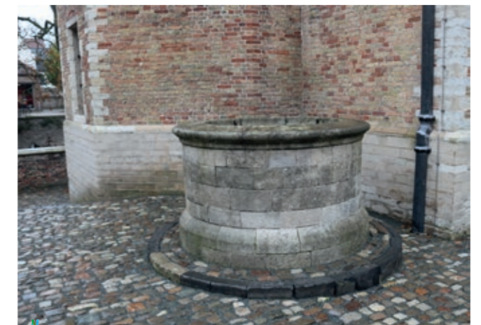
Foto. Openbare waterputten zijn er niet meer in Brugge. Bij tal van private huizen zijn echter wel nog steenputten of putten aangesloten op de moerbuis van weleer aanwezig. Deze zandstenen put bevindt zich aan de oostvleugel van het Gruuthusepaleis. Foto Arnout Zwaenepoel.
