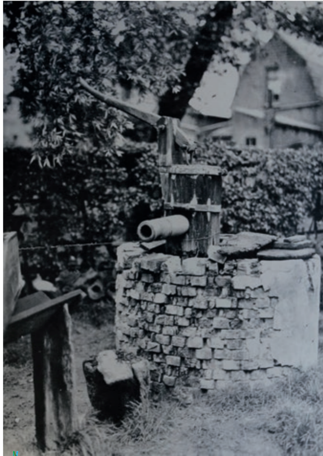
Foto. Een oude welput met later daarin geplaatste houten pomp in een oude achterplaats van het in 1944 verwoeste gedeelte van de Langestraat in Oostburg, omstreeks 1900. Foto overgenomen van Aalbrechtse (1967).
