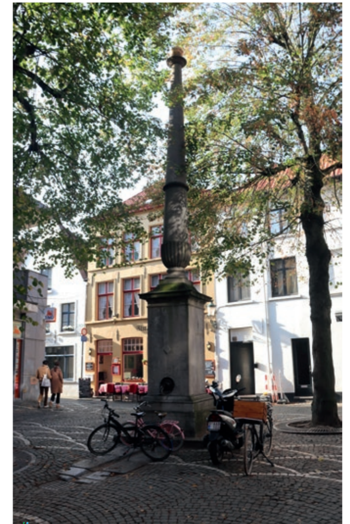
Foto. De waterpomp in de Sint-Amandsstraat dateert van ca. 1820. Ze bestaat uit een hoge vierkante sokkel van arduin met een metalen luik, ijzeren arm en koperen tuit. Ze wordt bekroond door een vereenvoudigde kandelaberzuil met op de top een vergulde bol. De pomp werd aangesloten op een bronput met ondrinkbaar water. De pomp is een beschermd monument sedert 2002. Foto Arnout Zwaenepoel.
