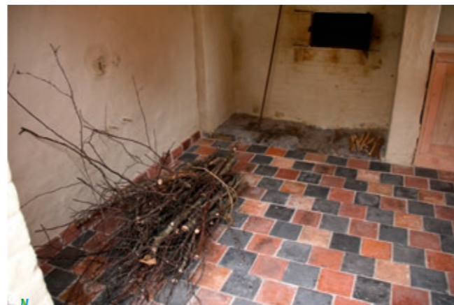
Foto. Met twee tot vier bussels rijshout wordt de bakoven tot 300 °C gestookt. Foto Arnout Zwaenepoel, 2016.
