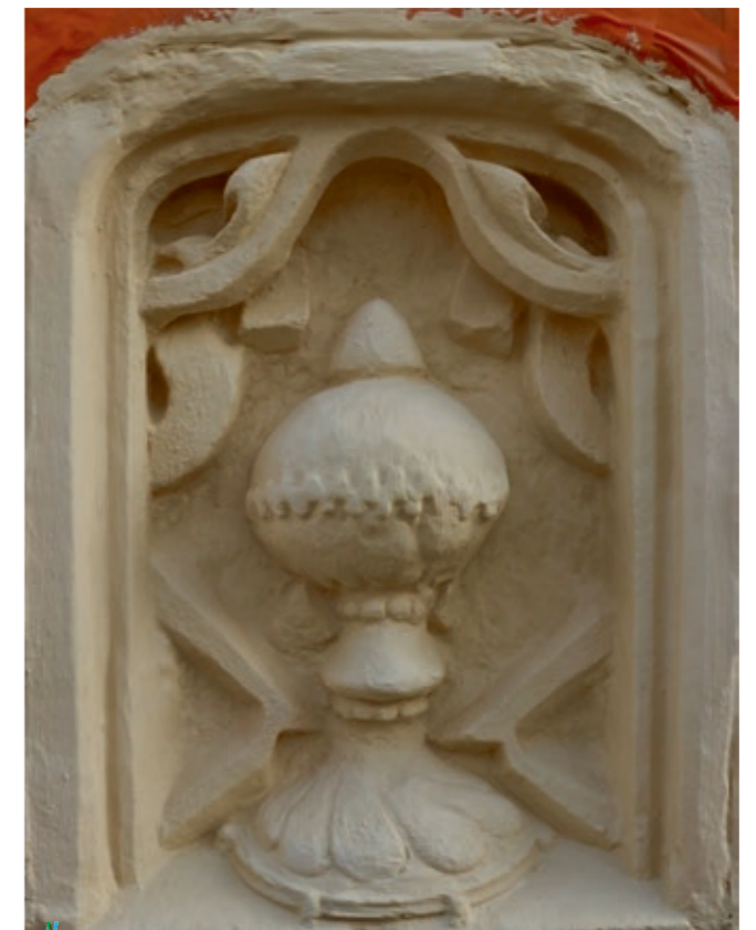
Twee foto's. Voormalige brouwerij in restauratiefase en pas herschilderde nis met gouden beker van 'In de Gouden Cop', op de hoek van de Noordzandstraat en de Kopstraat. Foto Arnout Zwaenepoel, 2019.
