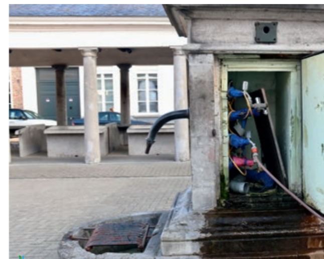
Foto. De pomp op de vismarkt werkt niet meer als pomp. De armen van alle pompen in de binnenstad zijn tegenwoordig vastgelast of met een slot onbruikbaar gemaakt. Een moderne watertoevoer zorgt echter wel nog voor de watervoorziening van de viskramers op de Vismarkt. Foto Arnout Zwaenepoel.
